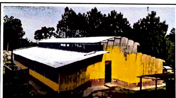
Foto 4: MUESTRA DE LA INSTALACION DE LAMINAS
