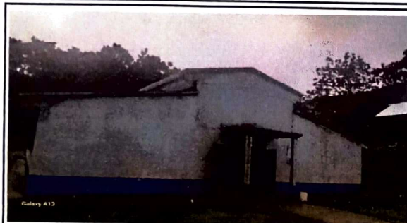
Foto 1: MUESTRA DEL LAVADO DE PARED ANTES DE PINTAR
