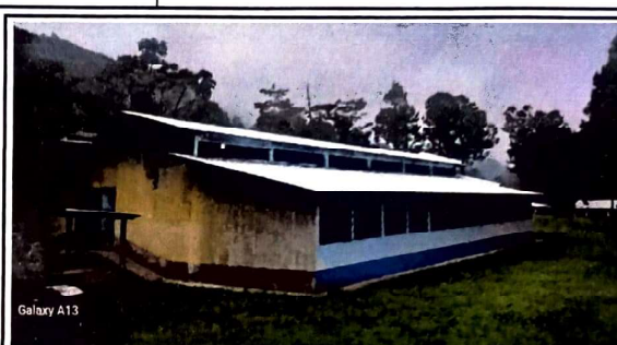
Foto 2: MUESTRA DE LA COLOCACION DE TECHO
