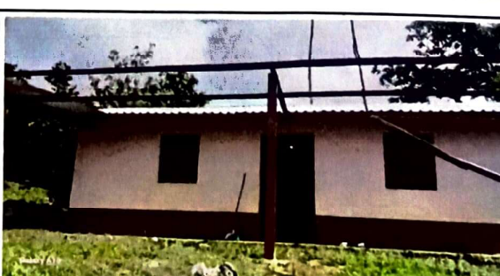
Foto 6: MUESTRA DE LA COLOCACIÓN DE TECHO E INSTALACION DE CORREDOR
